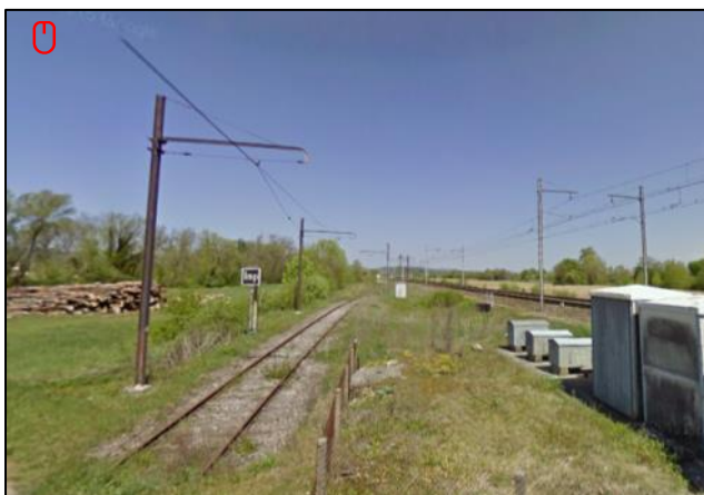
La voie au niveau du PN41, vue en direction de Pont-d'Ain.
