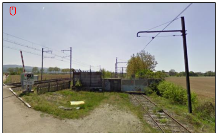
L'entrée du camp au niveau du PN41.
