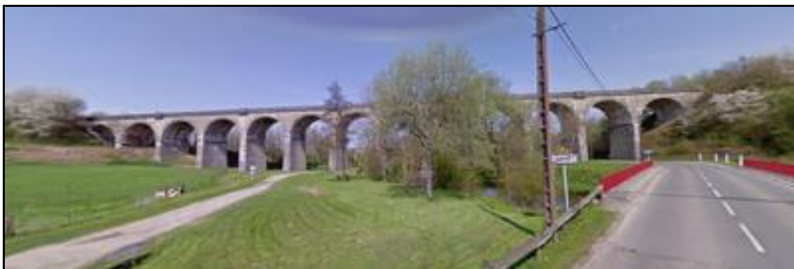
Haut de 27 m et long de 187 m, le viaduc d'Ohis compte 13 arches plein cintre.
