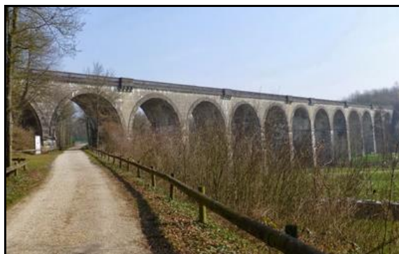
Haut de 27 m et long de 187 m, le viaduc d'Ohis compte 13 arches plein cintre.
