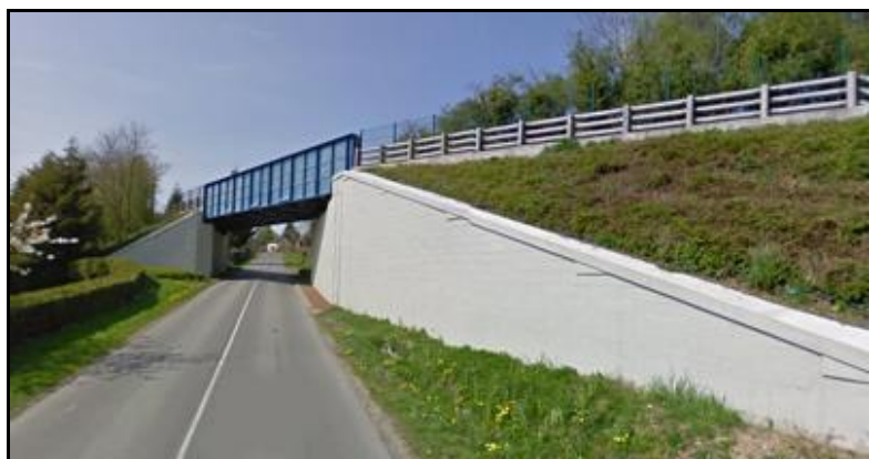
Ci-contre, le pont métallique sur la RD 31
