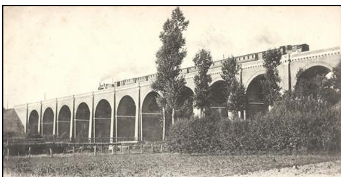
Haut de 27 m et long de 187 m, le viaduc d'Ohis compte 13 arches plein cintre.
