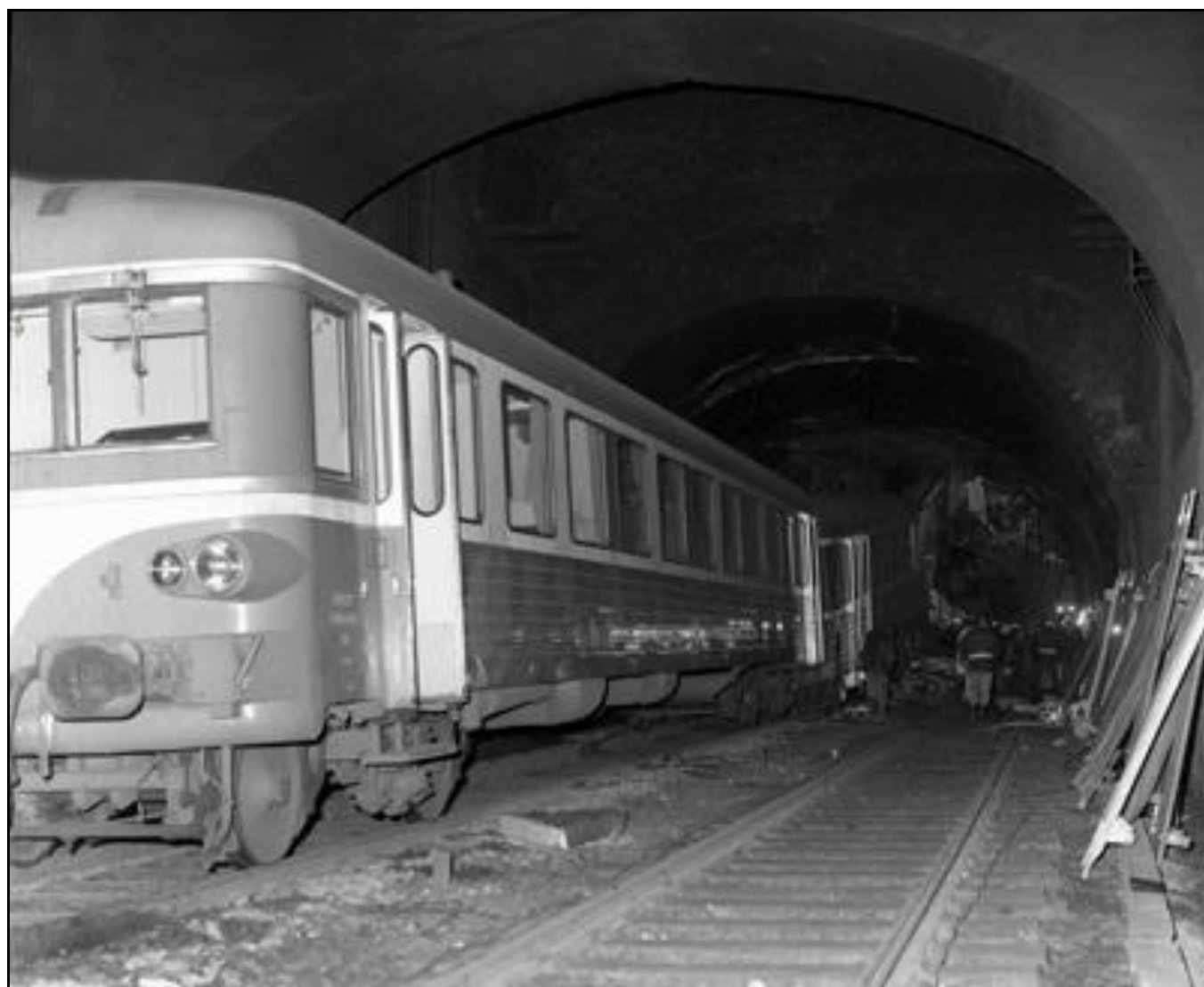
Vue générale du lieu de l'accident Au premier plan, au-dessus de l'autorail, la cloche résultant du dynamitage de la première guerre mondiale Au fond, 20 mètres plus loin, l'effondrement et le train encastré dans la voûte
