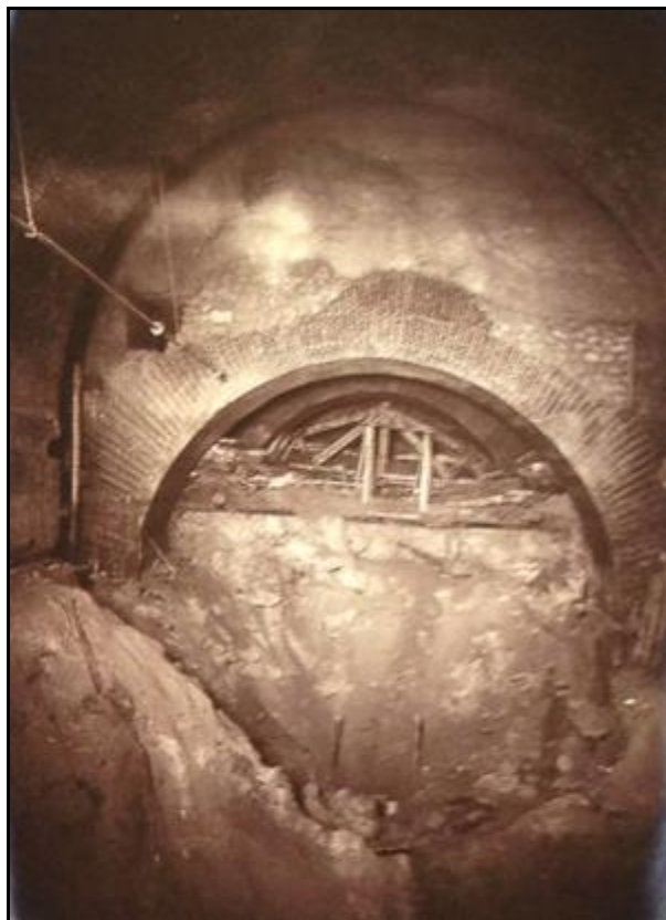
Construction des arcades de soutien alors que le tunnel, dans le bas de la photo, n'est pas encore dégagé
