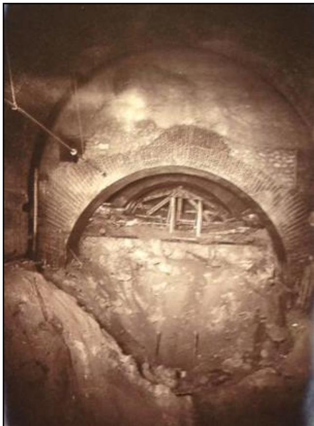
A gauche, construction des arcades de renfort alors que le tunnel, dans le bas de la photo, n'est pas encore dégagé
