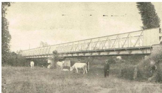
L'ouvrage d'art le plus important était situé sur la *Besbre*, en amont de Vaumas. Remplaçant un pont précédemment construit en bois, il a été déposé vers 1950.
