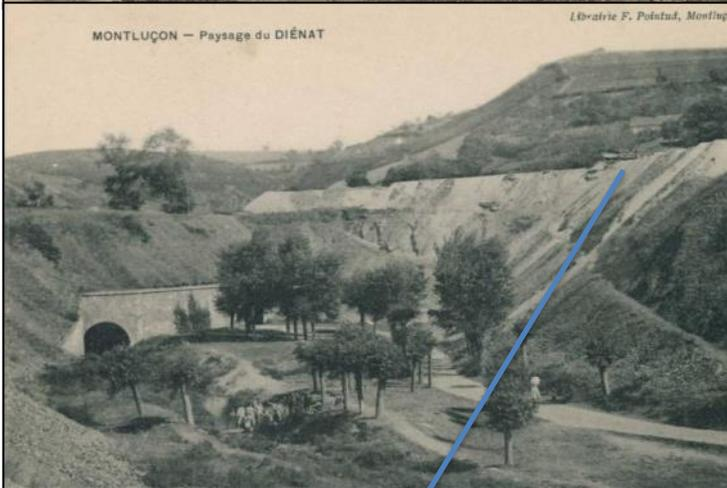
Deux faux tunnels seront construits pour livrer passage respectivement au *Lamaron* et au *chemin du Robinson* (ci-contre, vus du côté est et côté ouest). Un troisième petit faux tunnel sera construit pour la ligne de chemin de fer PO de Montluçon à Moulins, ouverte en 1859. Il est fort probable que les piles du viaduc soient toujours présentes sous le remblai.
