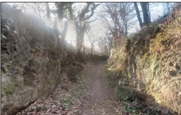
Le **PLAN INCLINE DE MARIGNON** – parfois nommé de *Rimart* –, long de 806 mètres, permettait de rattraper une dénivellation de 135 mètres avec une pente de 16,5%.
