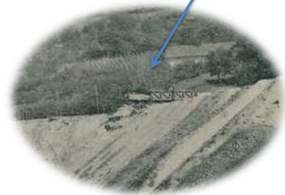
Ci-contre, les wagons déversent les scories des usines de Montluçon. Le chemin de fer minier de fer continua d'être utilisée pour l'évacuation des laitiers des hauts fourneaux vers les crassiers du *Diénat* jusqu'en 1942-1943 puis la voie fut déposée.
