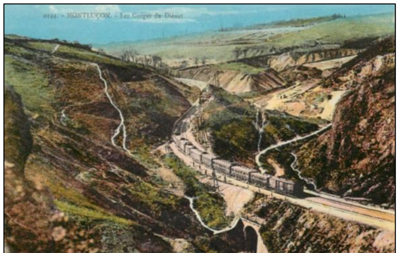
Les Gorges du Diéna, entre Montluçon et Commentry La direction de Montluçon est au fond.
