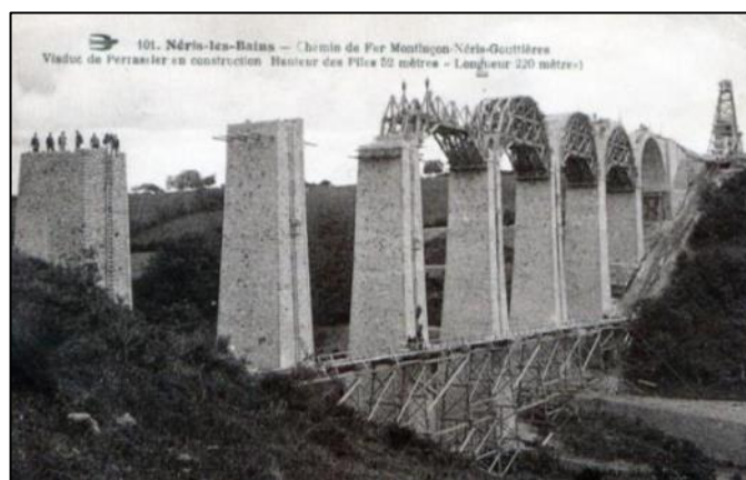
Construction du viaduc de Perrassier, entre Montluçon et Nérès-les-Bains
