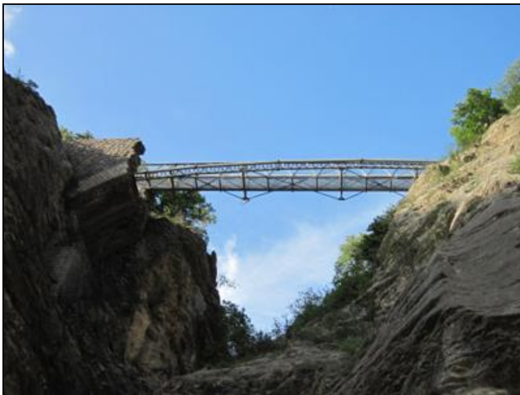
La passerelle vue de dessous avec la naissance de l'arche surbaissée de l'ancien pont détruit
