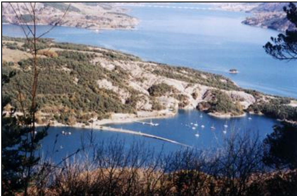
Au premier plan, le viaduc qui plonge dans le lac
