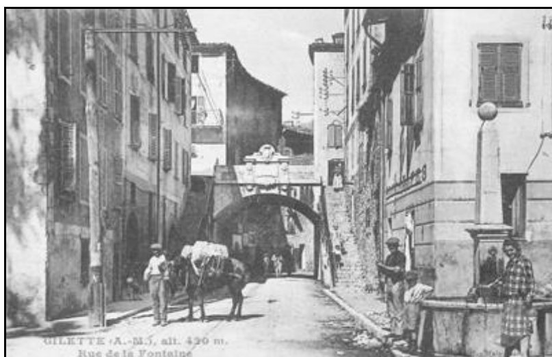
Les rails du tramway sont sur la gauche de la chaussée
