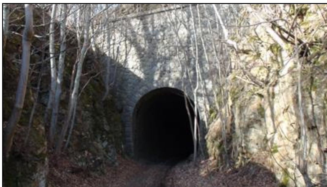
La sortie du tunnel
