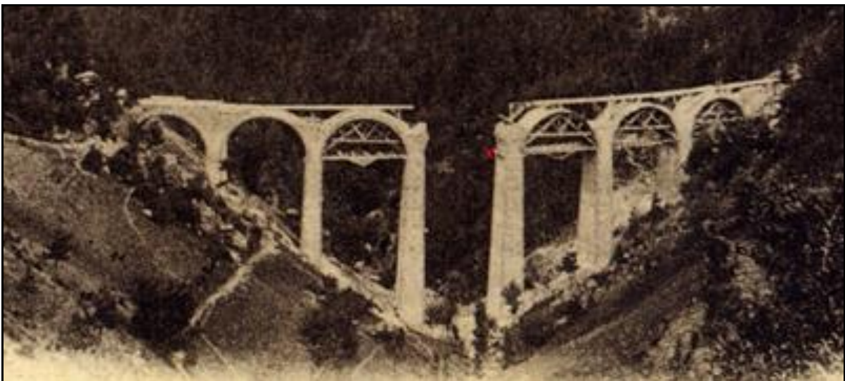
Prise par l'amont après l'accident, une autre photo du viaduc montrant les amorces de l'arche écroulée La petite croix rouge indique la position du corbeau qui a lâché On notera que la troisième arche, à droite de l'arche accidentée, a reçu son cintre
