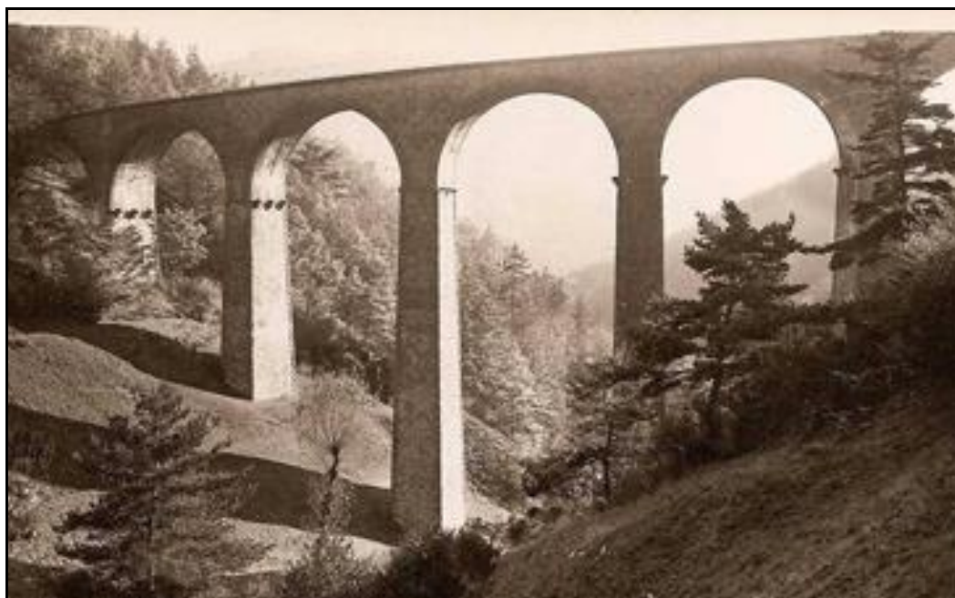
Enfin, le viaduc peu après sa finition Les corbeaux ayant servi au soutien des cintres, sont ici bien visibles
