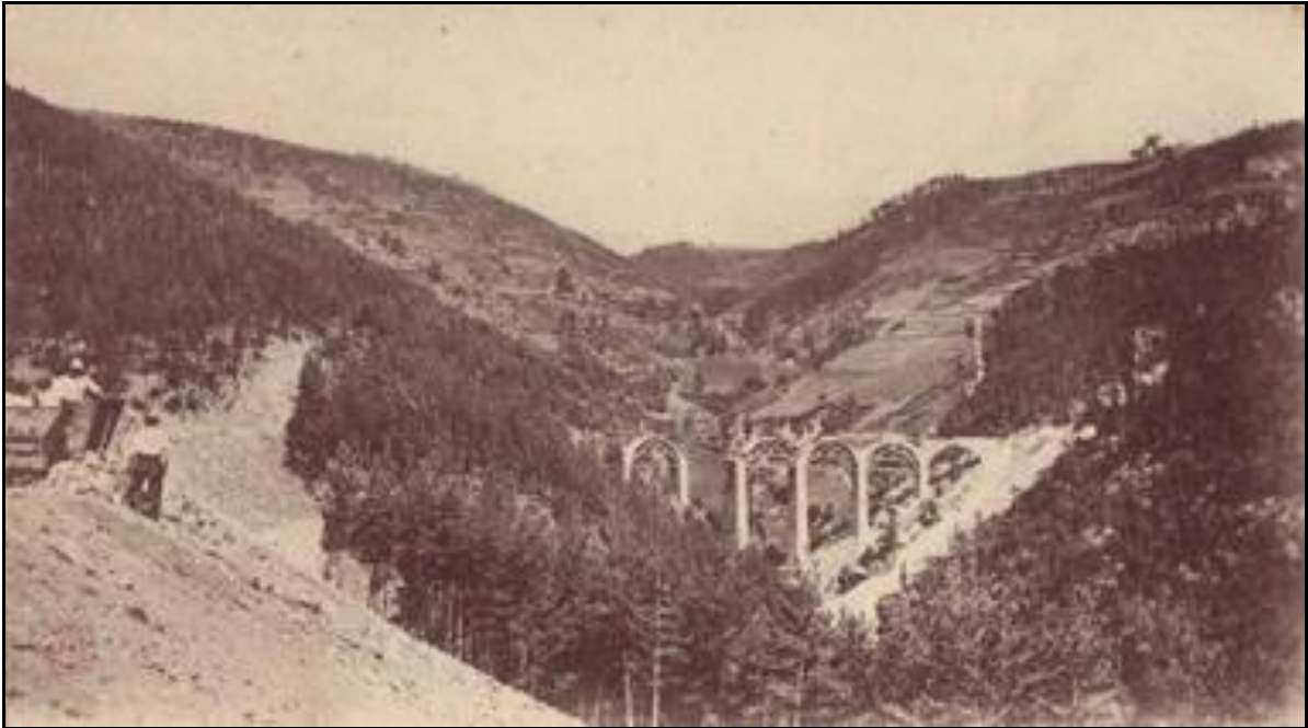
Prise par l'aval, photo intéressante montrant la construction du viaduc peu de temps avant l'accident Le cintre en bois de la troisième arche n'est pas encore posé Mais celui de l'arche centrale (quatrième arche) est déjà présent
