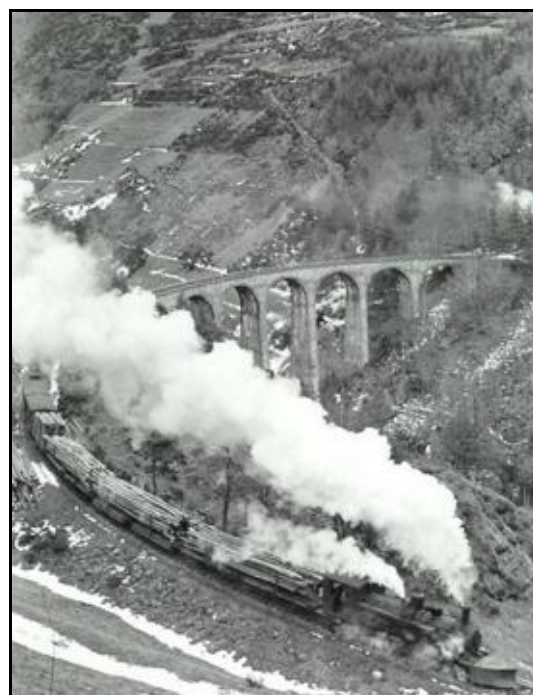
Enfin, le viaduc peu après sa finition Les corbeaux ayant servi au soutien des cintres, sont ici bien visibles
