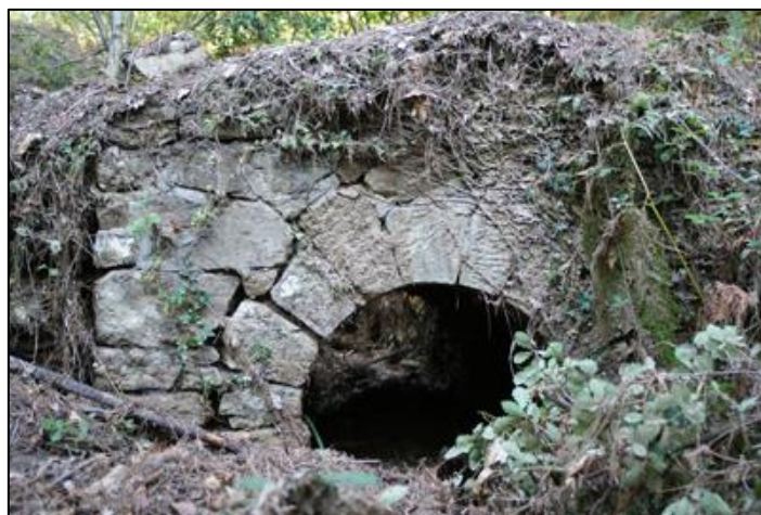
Un petit pont en maçonnerie sur lequel passait la voie minière
