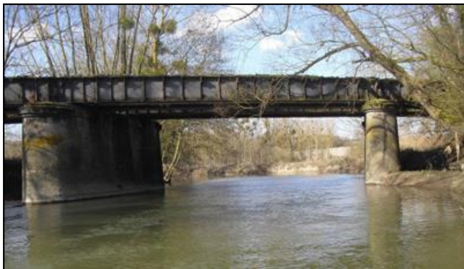
Le pont Est de Chaudefontaine à double tablier comportant trois travées métalliques reposant sur deux piles en maçonnerie
