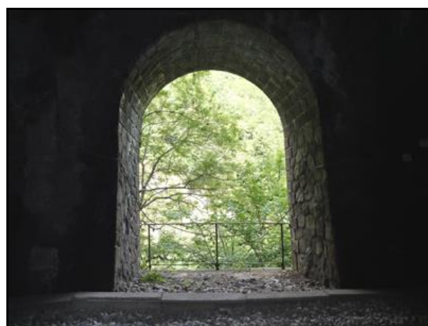
Ci-dessus et ci-dessous, la galerie de protection construite à la place de l'ancienne sortie du tunnel de Runac
