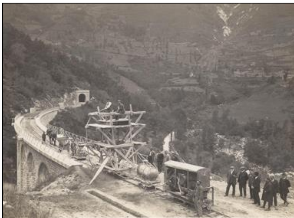
Une belle photo de l'entrée du tunnel de Runac lors de sa construction
