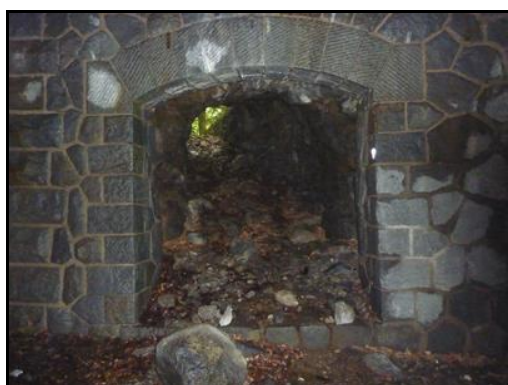
Ci-contre, une des niches de la paroi droite de l'ancienne galerie abandonnée du tunnel de Berduquet fait office de fenêtre donnant sur l'extérieur
