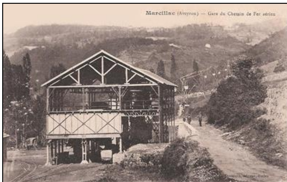
A Marcillac, l'arrivée du transbordeur aérien, visible à l'arrière-plan, la gare de transbordement, et le départ de la ligne minière vers Firmi
