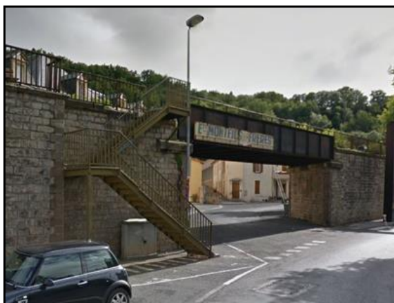
Le pont métallique de l'impasse Carnot
