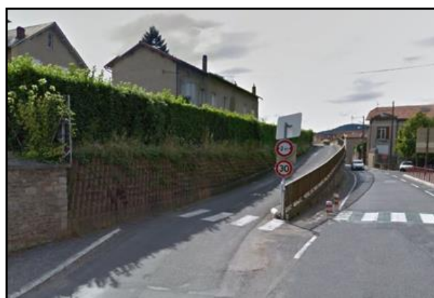
La fin du remblai maçonné, juste avant la gare
