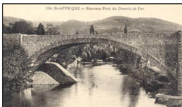
Puis le grand pont courbe de la Sorgue avec sa grande arche de 35 mètres d'ouverture, construit par le célèbre ingénieur Paul Séjourné
