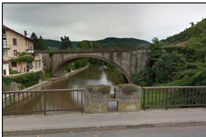
Puis le grand pont courbe de la Sorgue avec sa grande arche de 35 mètres d'ouverture, construit par le célèbre ingénieur Paul Séjourné
