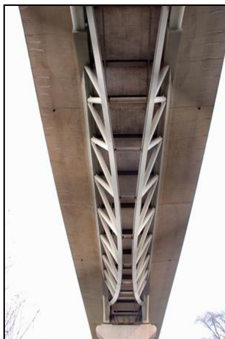
Ci-dessus et ci-dessous, détail du tablier avec ses arcs inversés sur lesquels repose le tablier béton
