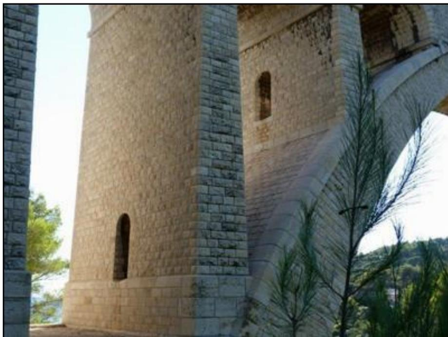
Chaque pile entre les élargissements possède une ouverture destinée à l'écoulement des eaux pluviales
