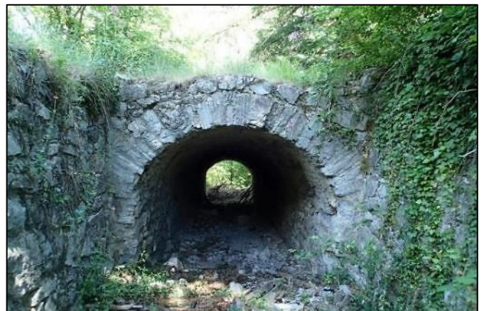
Pont de Garoute - Photo : JP Vigouroux
