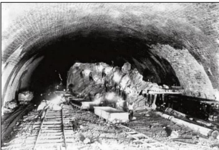
Cette autre photo est prise lors du dégagement du stross. Sauf erreur lié à un effet d'optique (à noter la taille des ouvriers !), de la gauche vers la droite on observe : une voie de 75 cm, une voie normale et une autre voie de 75 cm. A droite, noire, une locomotive à air comprimé sur voie de 75 cm.
