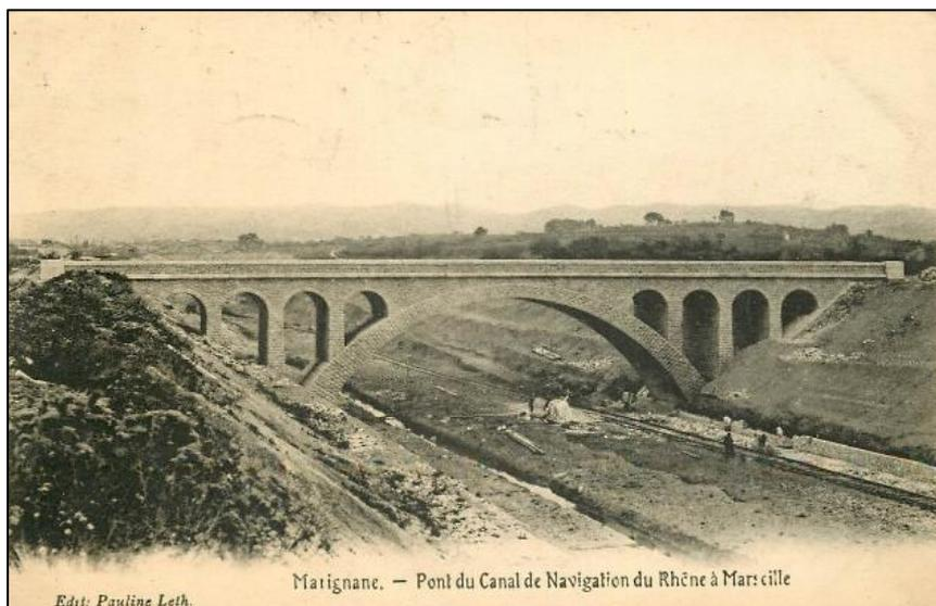
L'arche est détruite lors des bombardements d'août 1944. Les vues aériennes anciennes montrent que, jusqu'en 1971, année de construction du pont actuel, un tablier métallique reposait sur les arcades épargnées par les bombardements.
