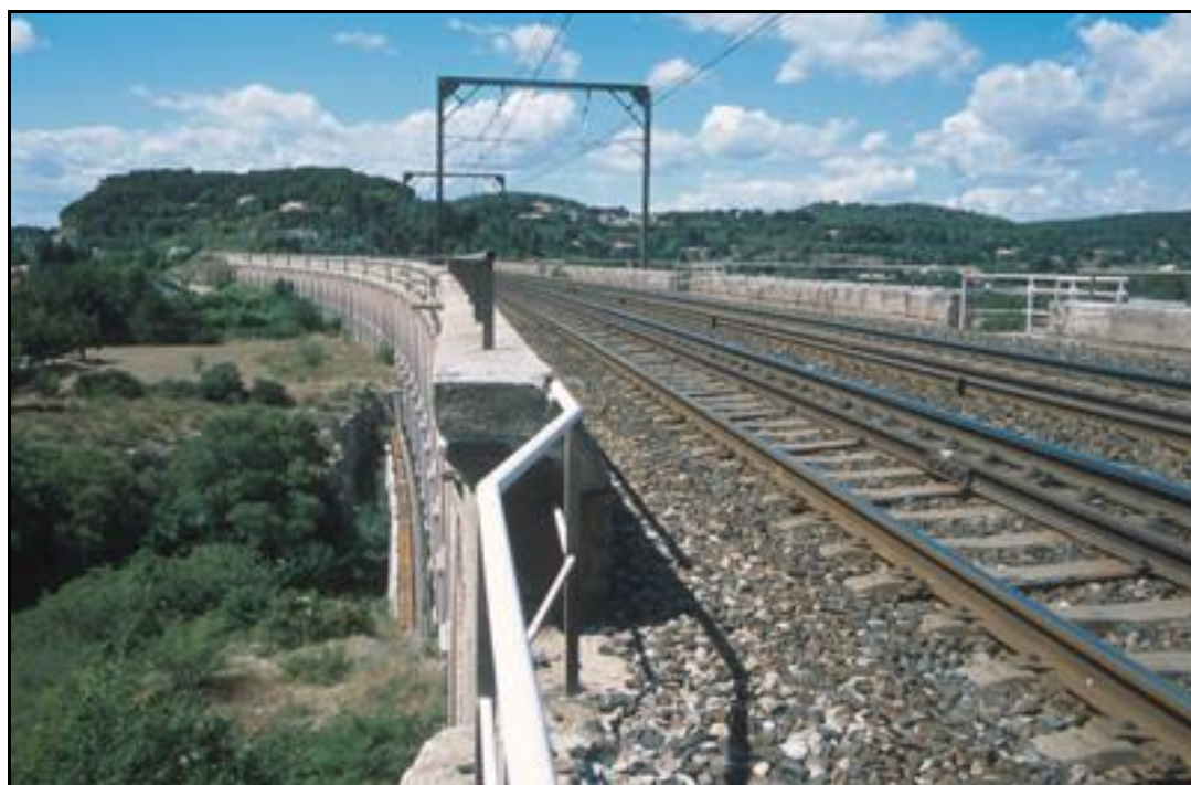
Le tablier du pont vu à contresens de la ligne
