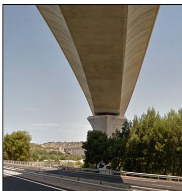
Le dessous du viaduc avec son tablier trapézoïdal
