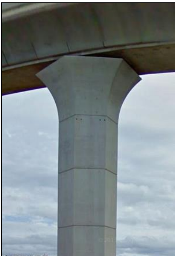
L'une des piles classiques du viaduc
