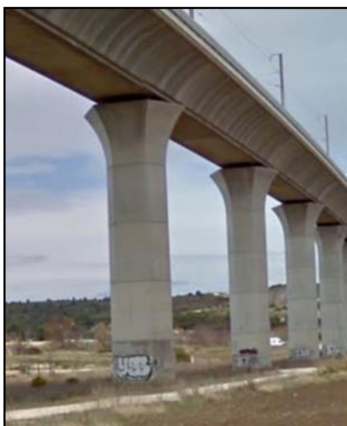
Le dessous du viaduc avec son tablier trapézoïdal
