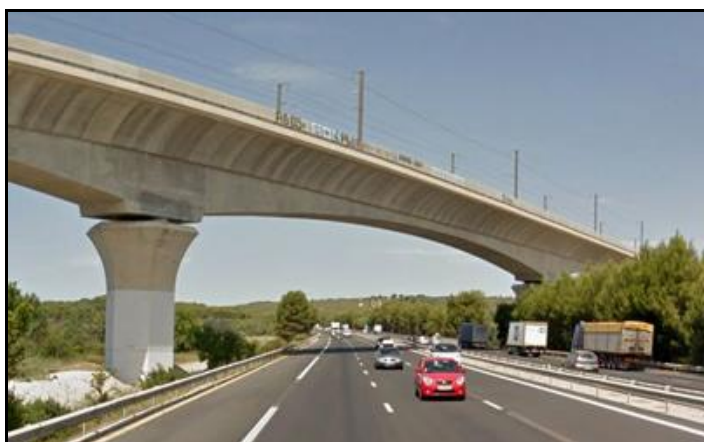
La grande arche de 100 mètres de portée obtenue par rotation des deux travées construites parallèlement à l'autoroute
