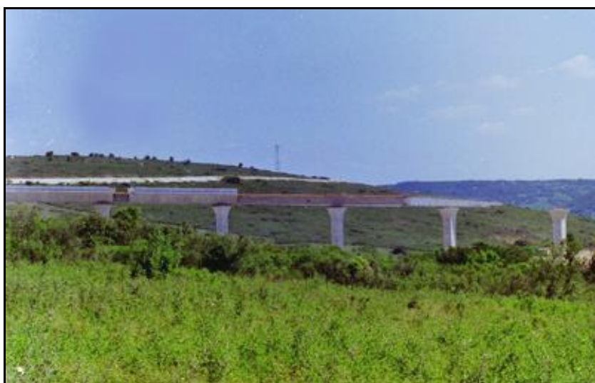
Le poussage des voussoirs sur les piles
