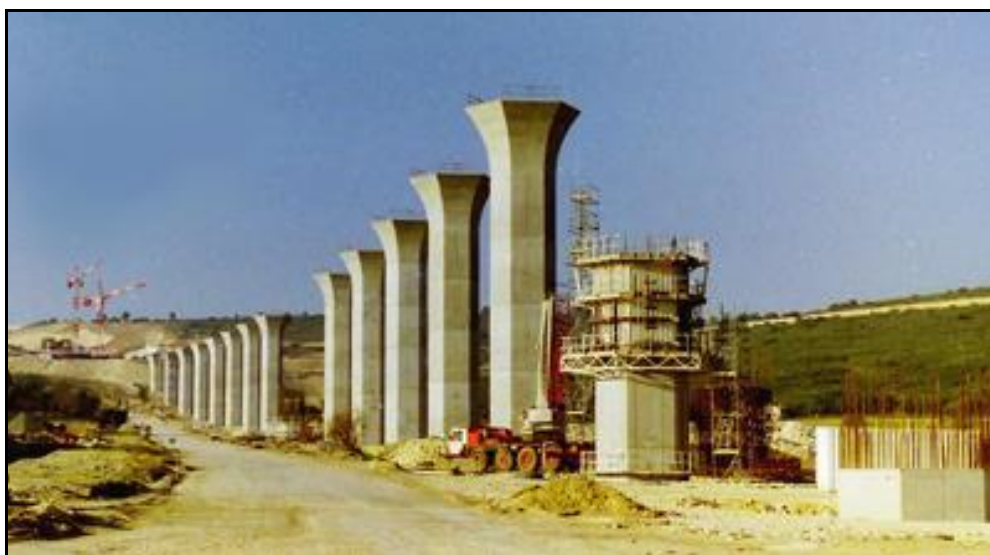
La construction des piles
