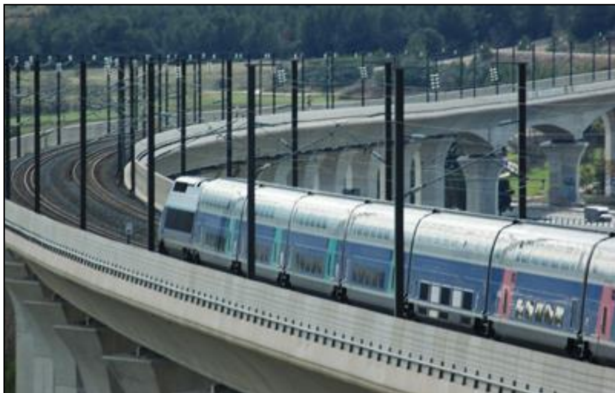
Le tablier du viaduc vu dans le sens de la ligne
