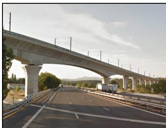
La grande arche de 100 mètres de portée obtenue par rotation des deux travées construites parallèlement à l'autoroute
