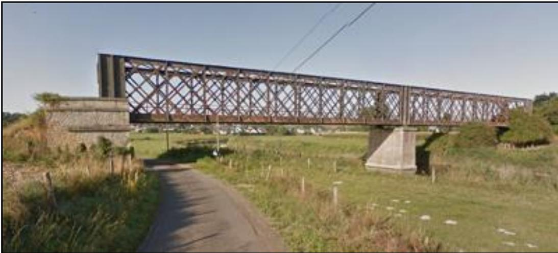
C'est un pont métallique cage comportant deux travées soutenues par une pile centrale en maçonnerie
