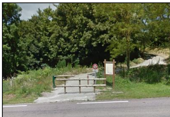
Le débouché de la voie verte sur la RD 979
