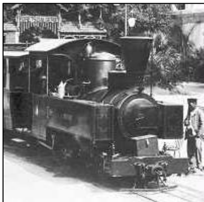
LOCOMOTIVE Type N° 6 de 7 Tonnes 500 à vide (9 Tonnes 750 en marche) Avec 2 essieux couplés et un essieu radial.
