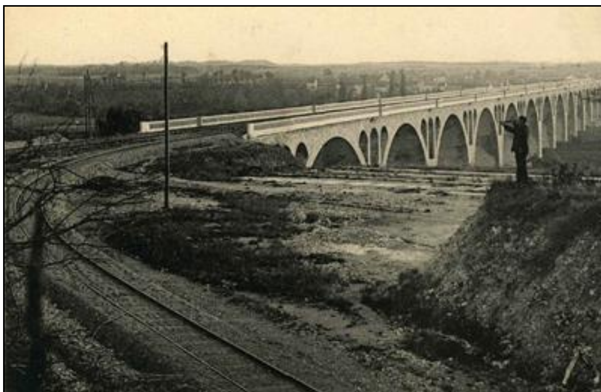
Le viaduc vu depuis le côté gare Au premier plan, la voie ferrée métrique de la ligne départementale vers Marçay
