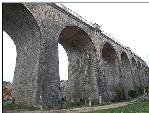
Contrairement au viaduc de Saint Satur qui a des parapets en maçonnerie, le viaduc de Ménétréol a des rampardes en fonte
