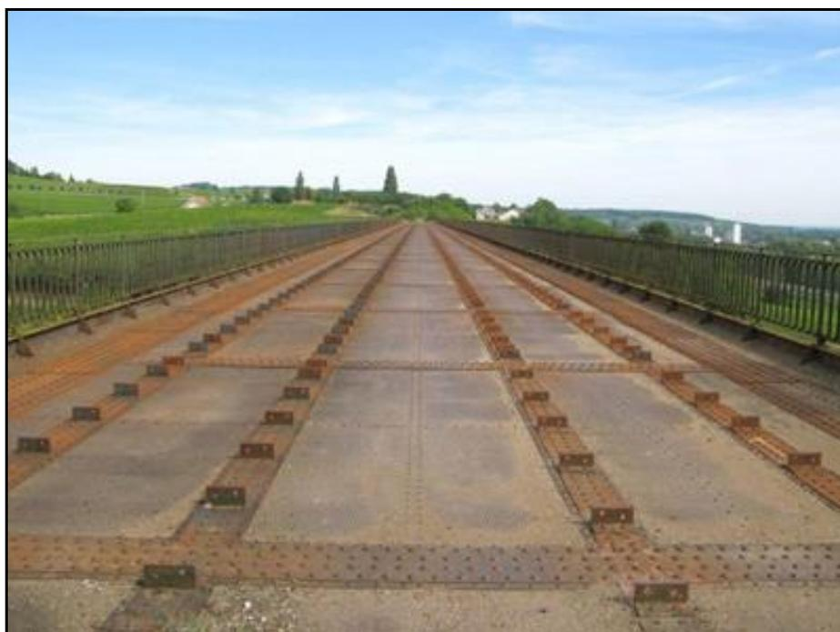
Vu à contresens de la ligne, avec la gare de Sancerre au fond, le dessus du viaduc qui laisse encore apparaître les fixations des traverses de ses deux voies. Malgré sa belle apparence, il commence à être fortement sujet à la corrosion.
