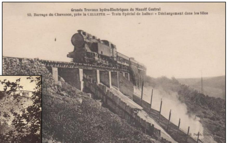
Au pied des silos, des wagonnets prenaient en charge le ballast.
