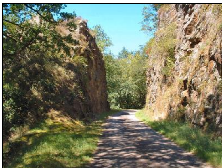
Puis une profonde tranchée en remontant vers Soursac
