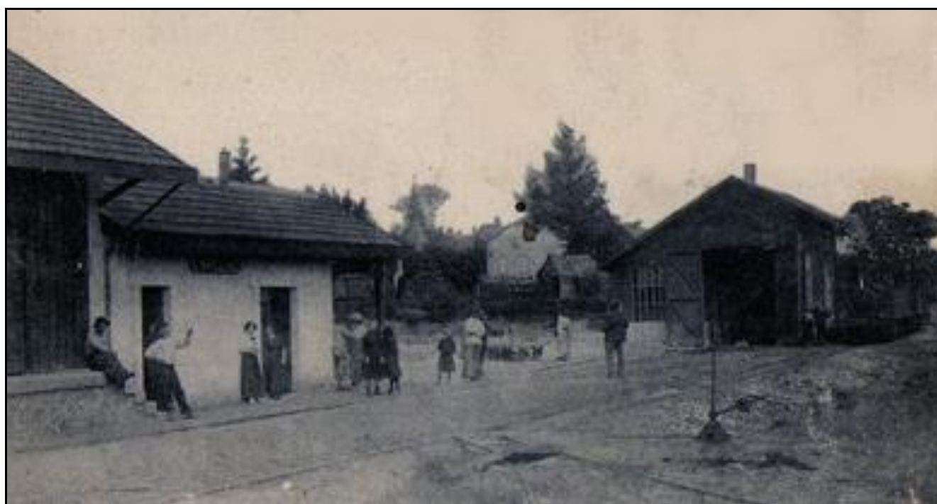
Vue ancienne de la gare de Lapleau montrant la partie de bâtiment qui subsiste aujourd'hui
