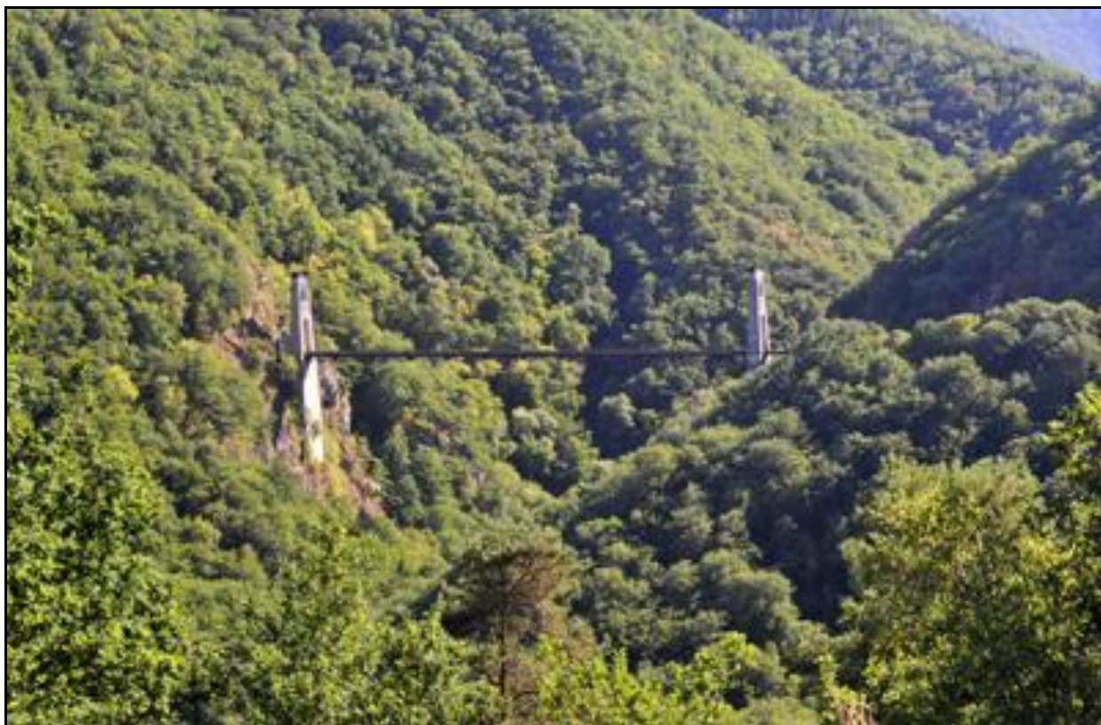
Le viaduc des Rochers Noirs dit aussi de Roche Taillade
