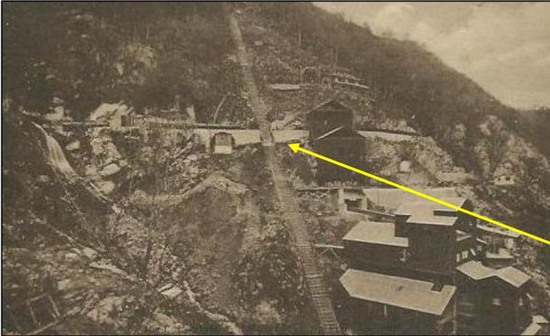
Sur cette autre carte postale, on aperçoit le plan incliné et les installations de fabrication du béton (concassage, triage, mise en silos avant d'être envoyé dans deux bétonnières de 1500 litres).
