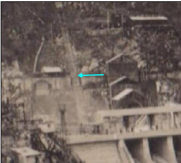
Ci-contre et ci-dessus, gros plan sur l'intersection entre le plan incliné et l'une des voies du chantier, en l'occurrence celle arrivant de la carrière, matérialisée par la flèche bleue.
