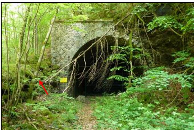
Il précède le dernier ouvrage de la ligne : le tunnel courbe de Confolent, 388 m de long, dont la galerie est en principe fermée car en partie inondable par les hautes eaux du lac de Bort
