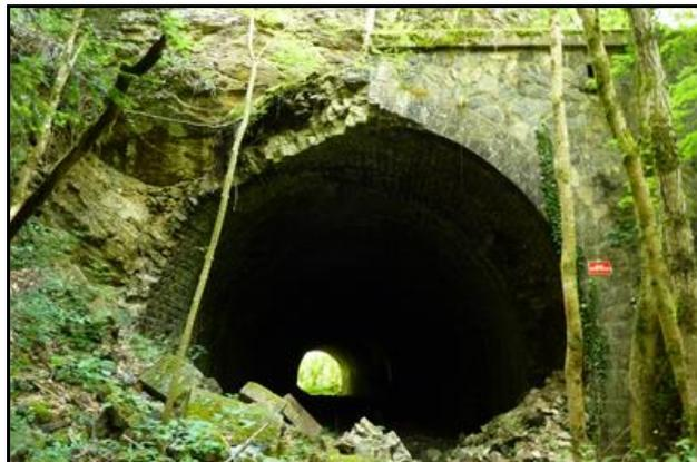
Quatrième souterrain de la ligne, le petit tunnel de Pradelles, dit aussi du Bois de la Jeanne, avec ses 71 m de long, dont le fronton d'entrée est partiellement écroulé
