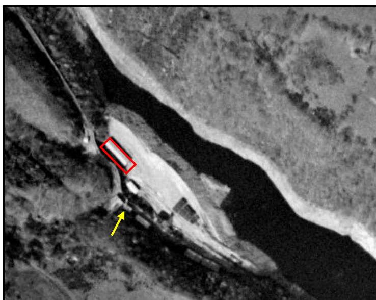
Vue aérienne du chantier de Vioux
