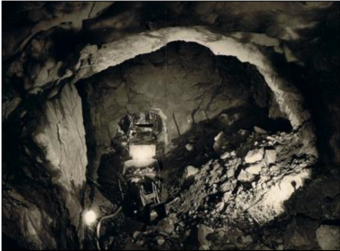
Au premier plan, un petit chargeur Decauville pour remplir les wagonnets
