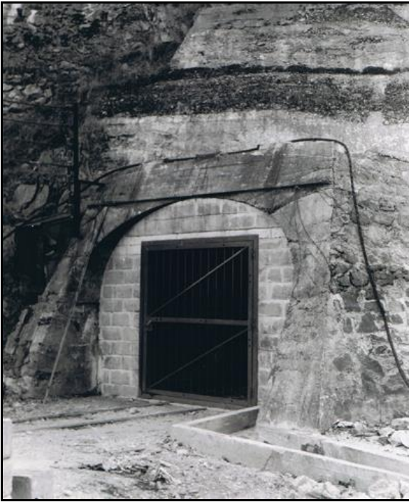
L'entrée de la fenêtre à l'époque du chantier
