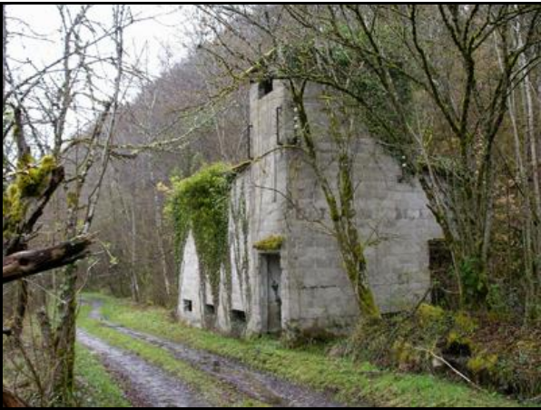
Le bâtiment solitaire du transformateur, aujourd'hui et...
