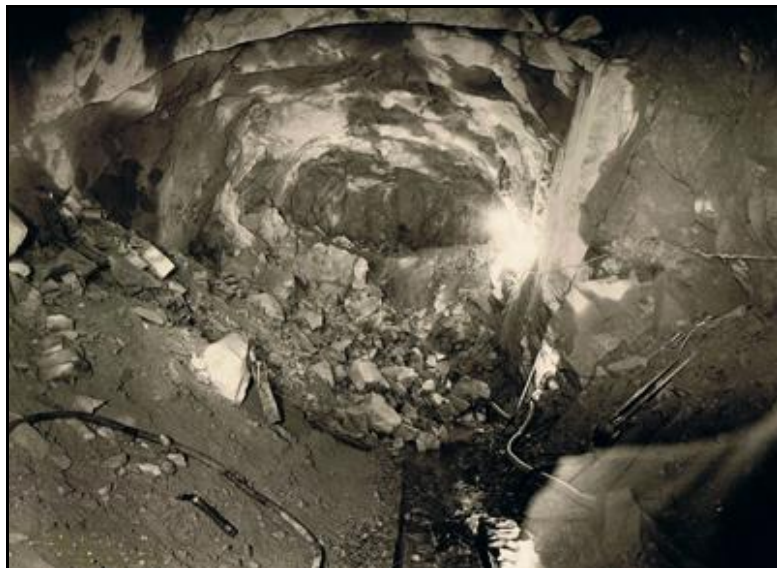
Ci-dessus et ci-dessous, deux belles photos du front de taille faisant apparaître la galerie pilote
