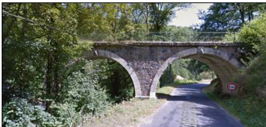
Le premier viaduc de la Borie Sèche
