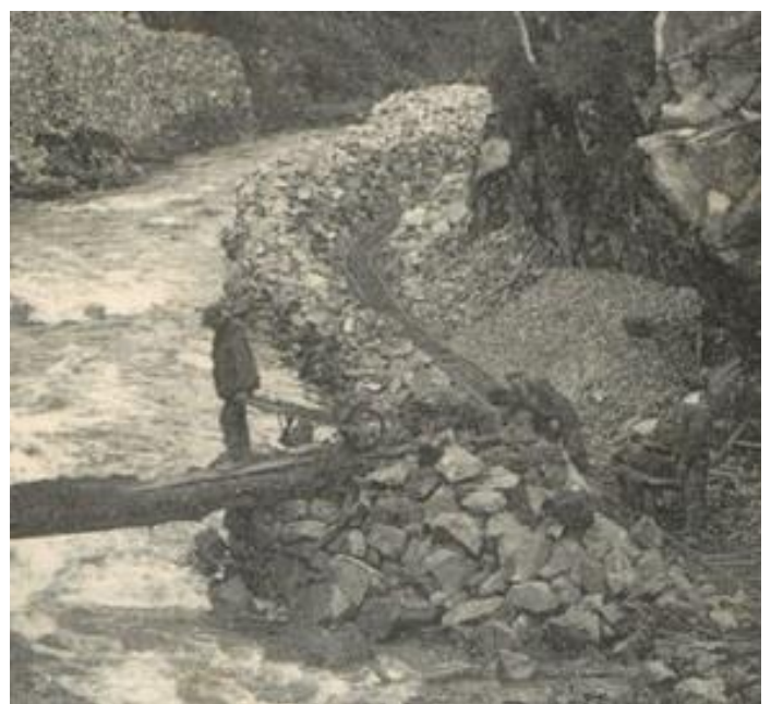
1203 Le Barrage des COMBES sur la Creuse, entre Aubusson et Felletin Travaux préliminaires
