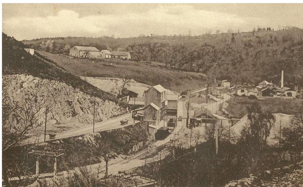
Ci-contre, les wagonnets en provenance des carrières arrivent aux concasseurs. Les wagons sont en attente ou en cours de chargement sur l'EP.
