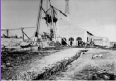
Machine d'épuisement. (mise en place d'une tige de pompe). Vue prise de l'ouest.
