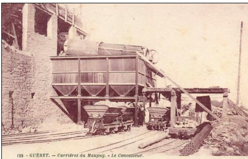
Ci-contre, le concasseur photographié quelques années plus tard du côté opposé. Il produisait soit du sable, soit des gravillons, soit de la pierre concassée pour les routes. Noter le tamis tournant au-dessus des trois trémies.
