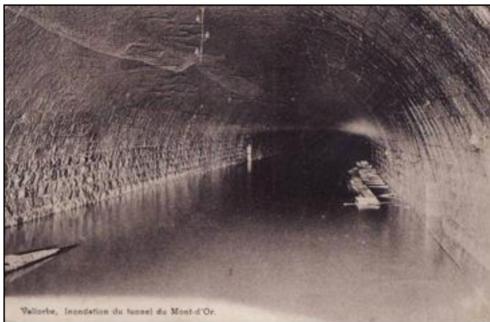
Le tunnel transformé en lac souterrain par le barrage temporaire
