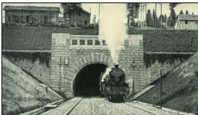
Ci-contre, l'entrée du tunnel peu de temps après sa finition, avec un train venant de Suisse sortant de la galerie
