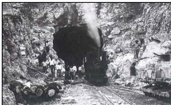
L'avancée des travaux côté suisse la galerie pilote a cédé la place à la galerie du tunnel proprement dit
