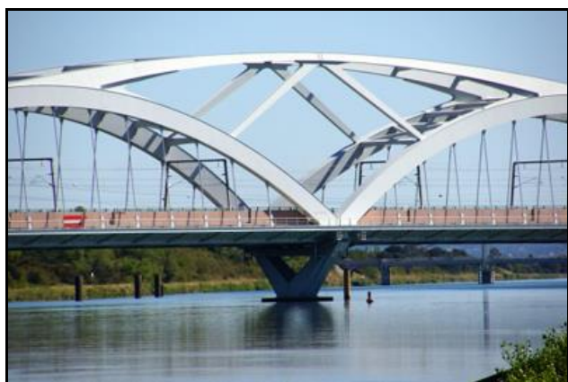
L'arc supérieur dont la finalité est d'apporter une rigidité complémentaire à l'ensemble car le pont est très légèrement courbe
