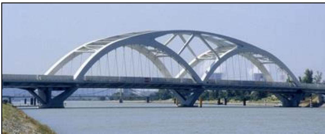
Ci-dessus et ci-dessous, position et détail des deux piles squelettes pyramidales inversées qui font la liaison entre les travées d'extrémités et les deux travées centrales en arc
