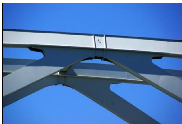
L'arc supérieur dont la finalité est d'apporter une rigidité complémentaire à l'ensemble car le pont est très légèrement courbe
