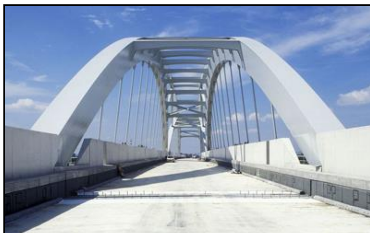
Le revêtement béton du tablier métallique, avant pose de voies
