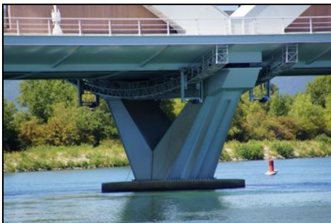
La pile centrale en V avec les nacelles mobiles qui permettent de contrôler l'état du dessous du pont
