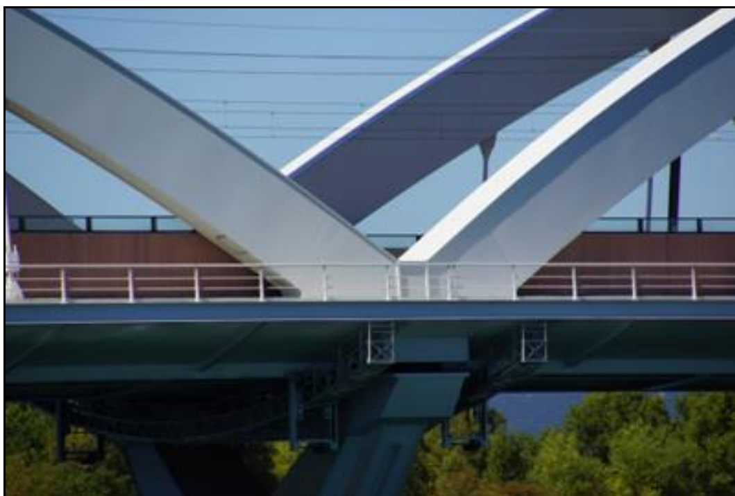
Au centre de l'ouvrage, liaison entre les arcs et le tablier sur la pile centrale
