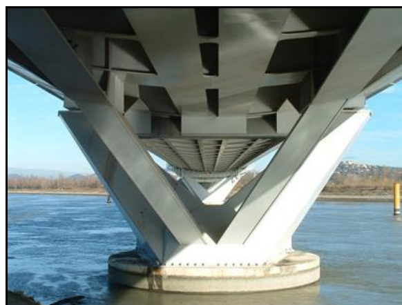
La pile centrale en V avec les nacelles mobiles qui permettent de contrôler l'état du dessous du pont
