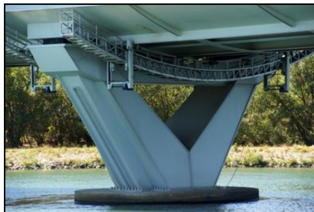
La pile centrale en V avec les nacelles mobiles qui permettent de contrôler l'état du dessous du pont
