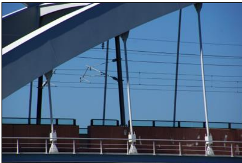
Détail des suspentes métalliques qui soutiennent le tablier
