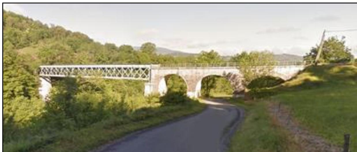
L'ouvrage comporte un tablier métallique encadré par deux avant-ponts en maçonnerie
