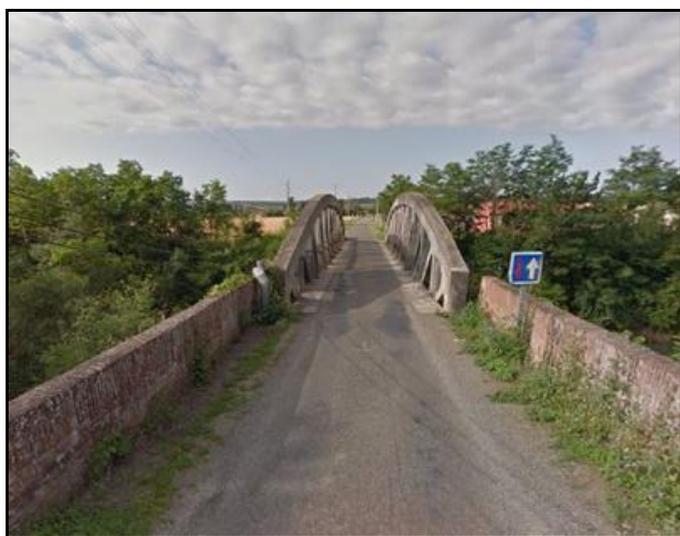
Ci-contre, le pont en béton sur l'Arize, avec poutres latérales en arc
