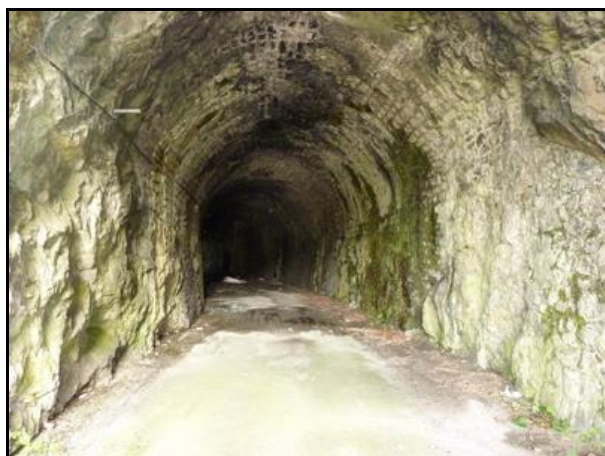
A noter que la roche étant de bonne qualité, le tunnel n'était pas maçonné partout
