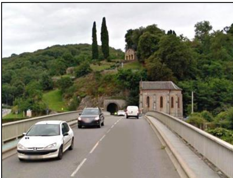
Le pont de la Garonne aujourd'hui avec l'entrée du tunnel du Calvaire
