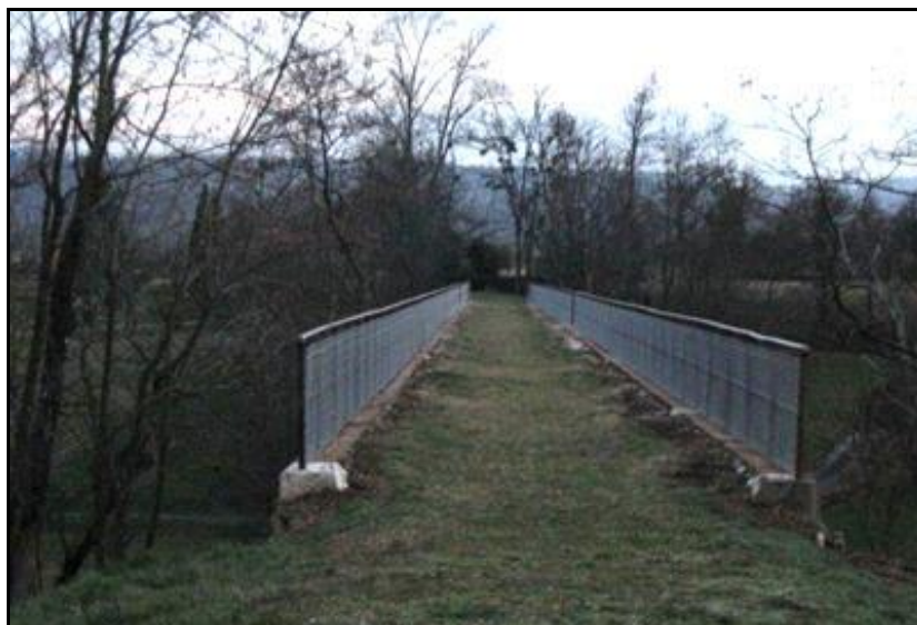
Le dessus de l'ouvrage
