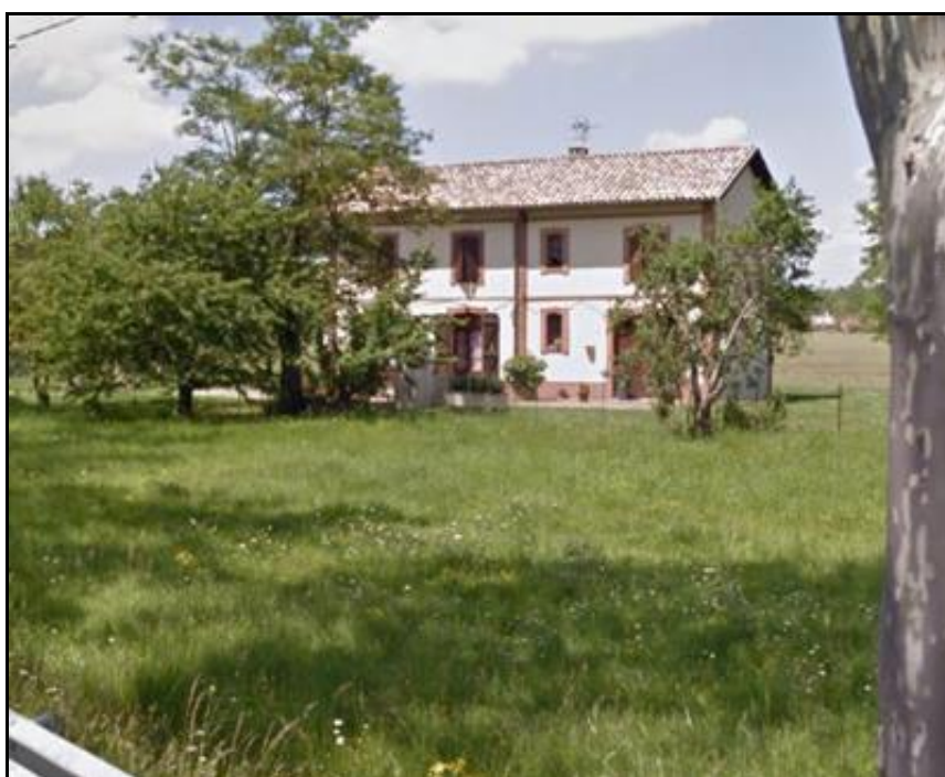
Le bâtiment voyageurs a été agrandi mais dans le style de la construction d'origine
