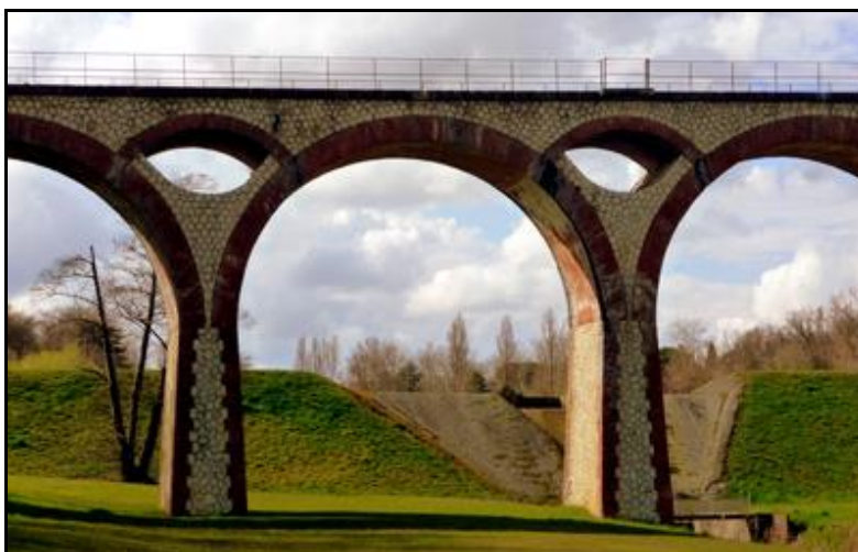
Le viaduc comporte 8 arches plein cintre dont les parements sont rehaussés de briques rouges et dont les tympans sont percés d'élégissements elliptiques
