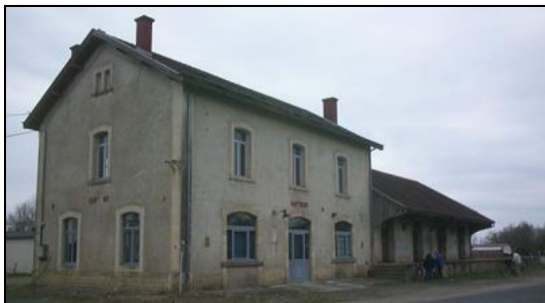
Et côté voies
