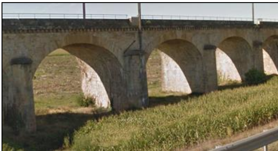
Détail des piles et du tablier
