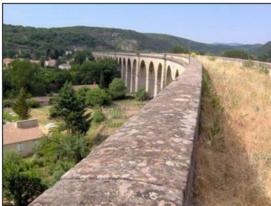
Le tablier du viaduc vu à contresens de la ligne
