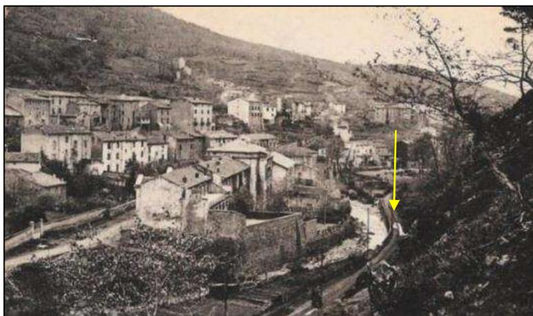
Ci-contre, la voie longe le Clédou (flèche jaune). Cet itinéraire a nécessité la construction d'un mur de soutènement.
