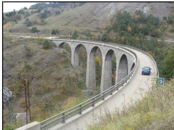
De même que le viaduc de la Roizonne, celui de la Bonne a été reconverti à un usage routier. Il comporte 7 arches plein cintre de 20 m d'ouverture pour une longueur totale de 180 m et 55 m de haut.
