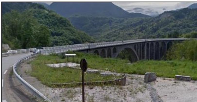
Ci-contre et ci-dessous, après fermeture de la ligne en 1945, des travaux ont été entrepris pour élargir le sommet du tablier et reconverter l'ouvrage à un usage routier
