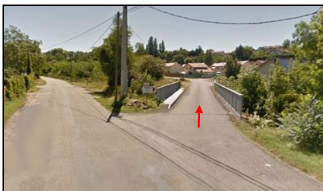
Le pont du Perous avec ses rambardes restaurées
