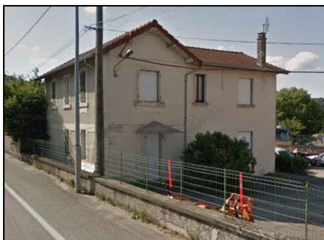
La gare CEN en bordure de la RD 518
