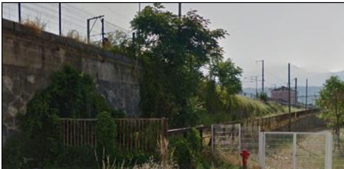
Après être passé sous ce pont, le petit train tournait à gauche et remontait cette longue rampe pour atteindre la gare de Voiron dont on voit le bâtiment dans le fond
