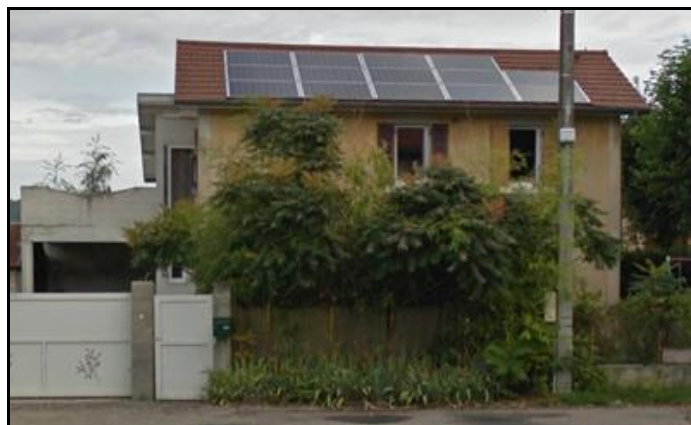
Des plaques photovoltaïques très "esthétiques"
