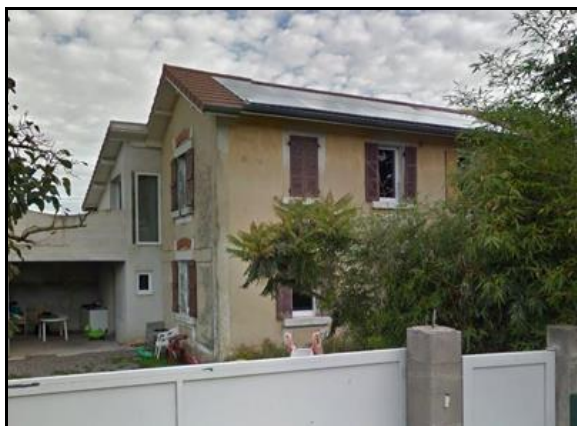
Un corps de bâtiment s'est rajouté à la construction initiale
