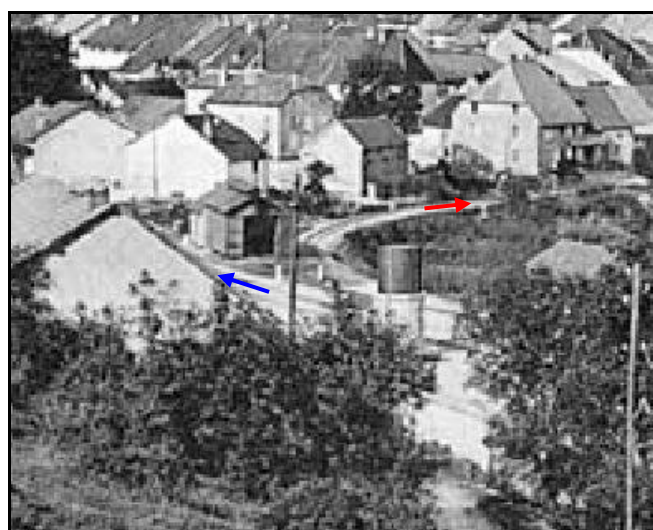
Vue depuis le chemin situé derrière l'hôtel des Lacs, la bifurcation en rebroussement de part et d'autre de la remise à locomotives A gauche, flèche bleue , la ligne vers Lons le Saunier ; et à droite, flèche rouge , celle vers Saint Laurent
